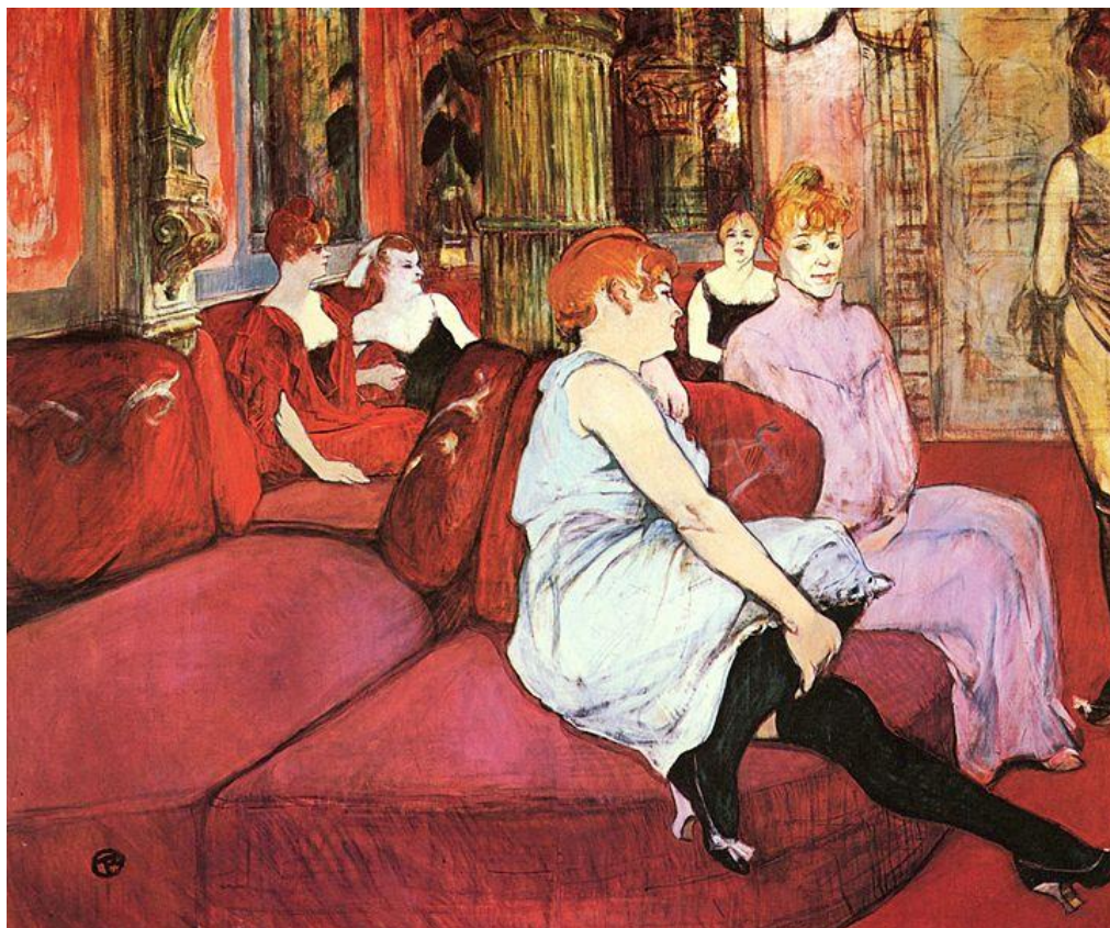
H. Toulouse-Lautrec: Interiér nevestinca
