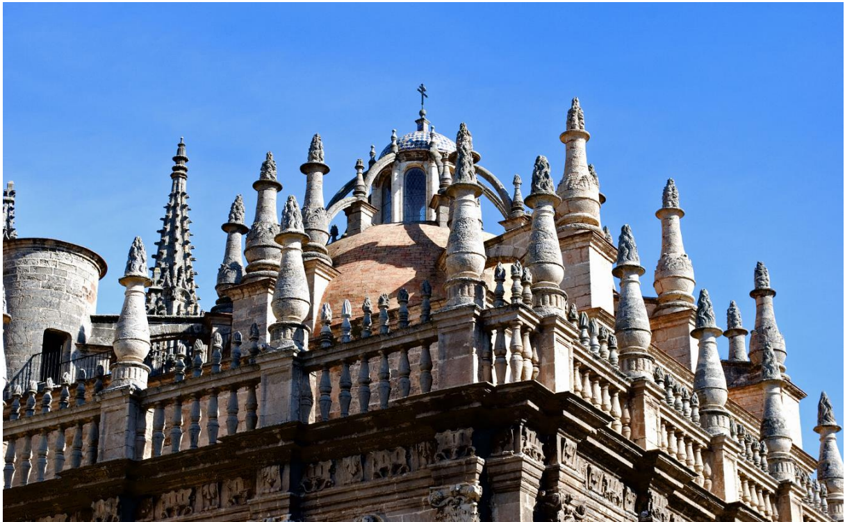
Exteriér katedrály v Seville (gotico florido, 16.st.)
